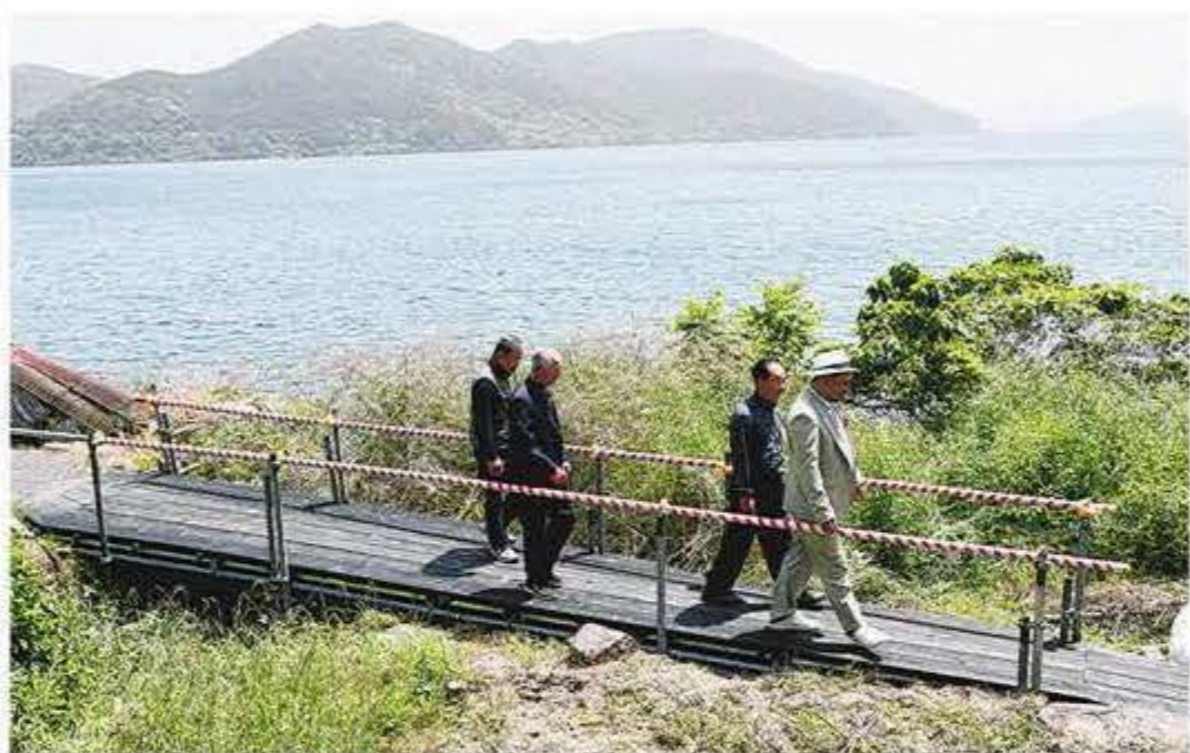
架け替え工事を終えた橋を渡り初めをする奥井代表や自治会役員ら＝近江八幡市の沖島で
