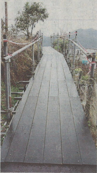
改修が完了した散策道に架かる橋＝近江八幡市沖島町で
