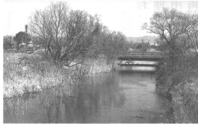
改修工事が計画されている「八坂放水路」
